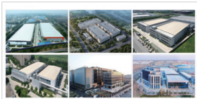
北京泰豪承建万国数据(廊坊)算力中心集群
