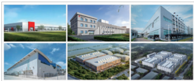
北京泰豪承建万国数据(北京)算力中心集群
