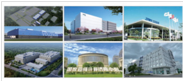
北京泰豪承建大型数据中心项目
